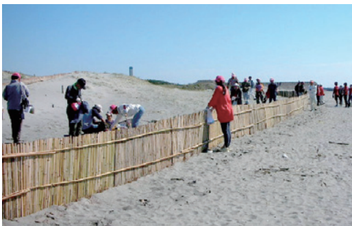
完成した堆砂垣
